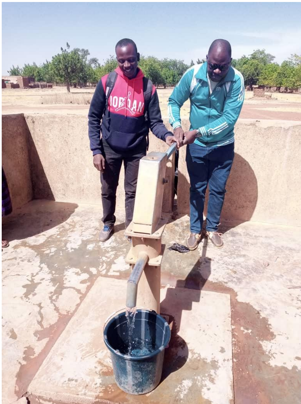
Figure 4: Un forage réhabilité
