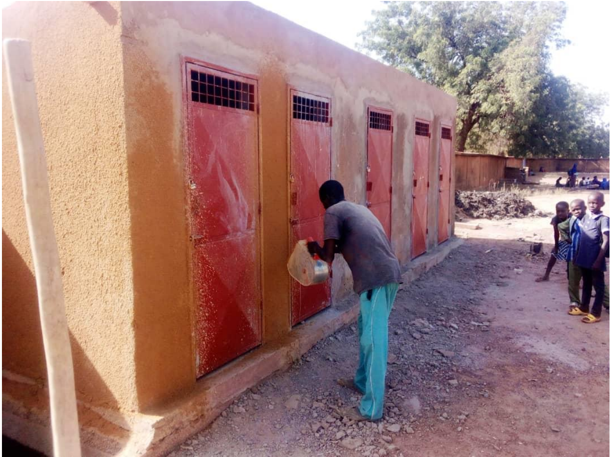
Figure 3: Construction d'une latrine
